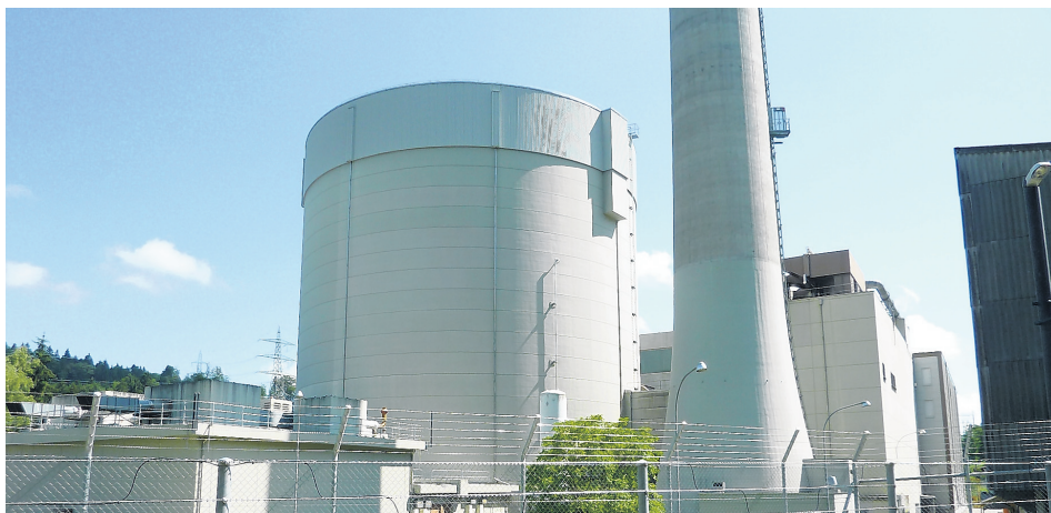
Das Atomkraftwerk Mühleberg, eines der weltweit ältesten AKW.
